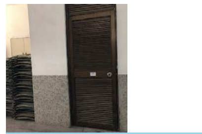
110 仁愛樓走廊 (北側)
